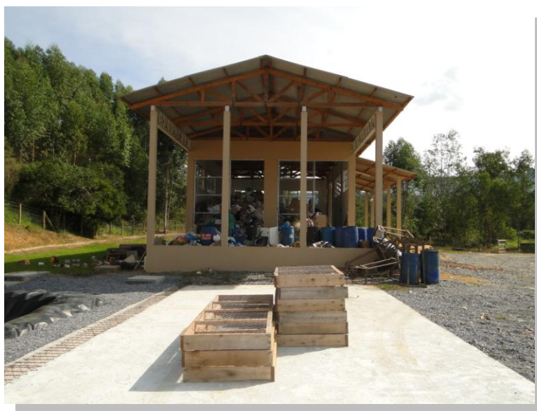
Figura 17 - Vista geral do centro de triagem. Fonte: Visita Técnica STE, 2010.
