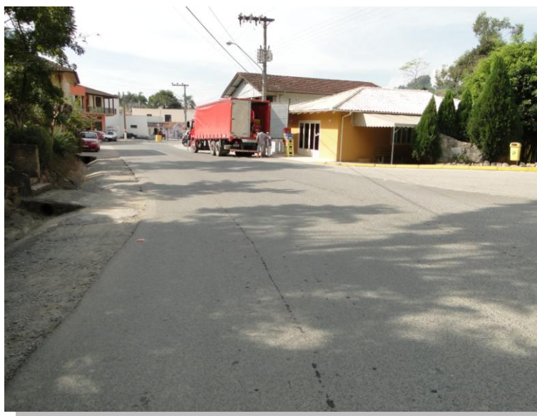
Figura 33 - Ponto de alagamento 04. Fonte: Visita Técnica STE, 2010.
