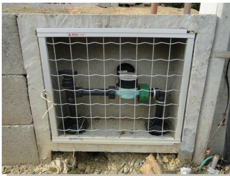
Figura 10 - Micro-medidor residencial com Hidrômetro – rede de abastecimento. Fonte: Visita Técnica STE, 2010.
