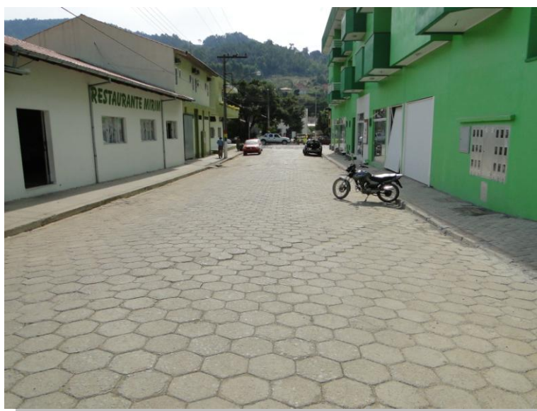
Figura 31 - Ponto de alagamento 02. Fonte: Visita Técnica STE, 2010.
