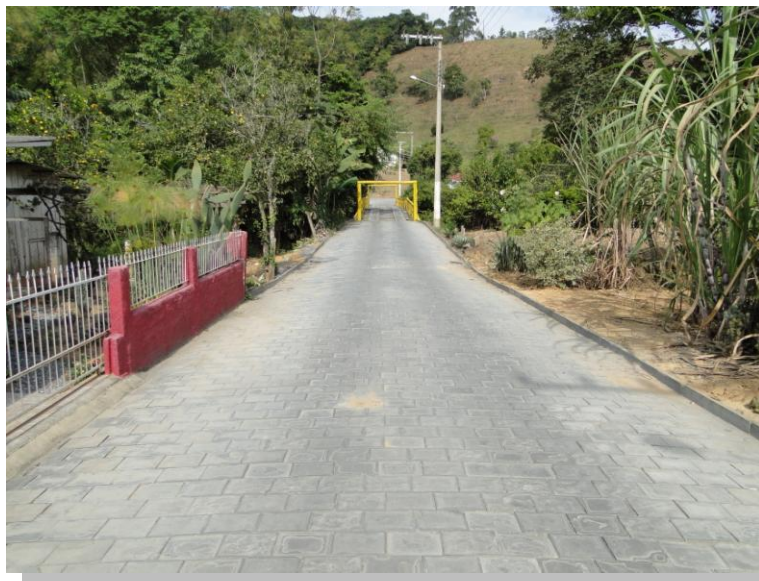
Figura 30 - Ponto de alagamento 01. Fonte: Visita Técnica STE, 2010.
