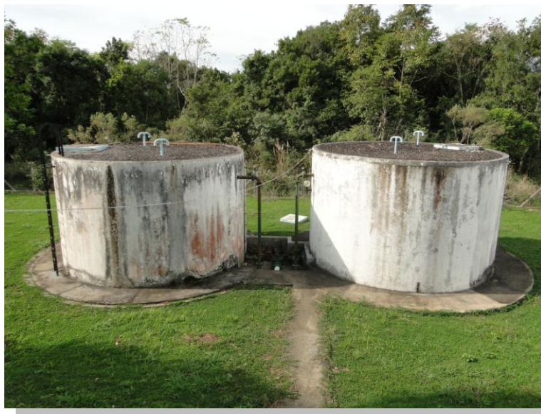
Figura 6 - Reservatórios. Fonte: Visita Técnica STE, 2010.
