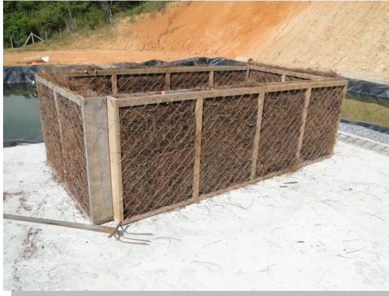
Figura 20 - Leira de Compostagem. Fonte: Visita Técnica STE, 2010.
