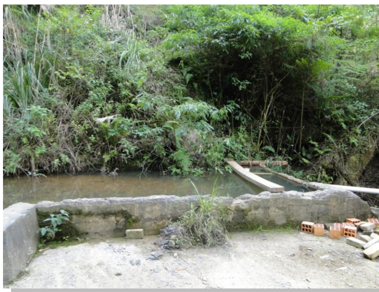
Figura 2 - Captação de água bruta - barragem de nível em concreto armado. Fonte: Visita Técnica STE, 2010.
